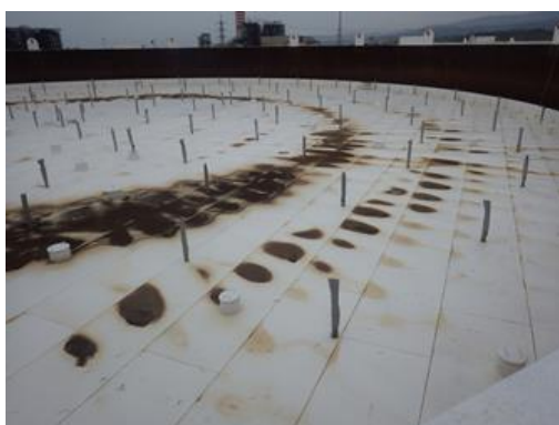
Figura 9 Il tetto galleggiante del serbatoio dotato di calze
