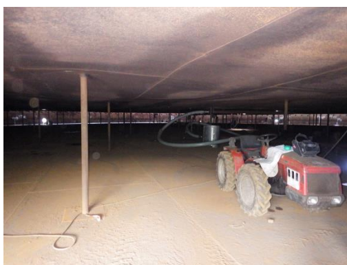
Figura 10 Lavori per l'installazione del doppio fondo
