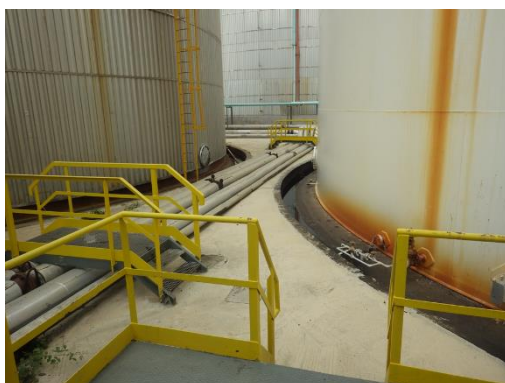
Figura 12 Bacino di contenimento con pavimentazione impermeabile
