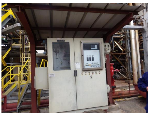
Figura 13 Cabina SME impianto CO boiler
