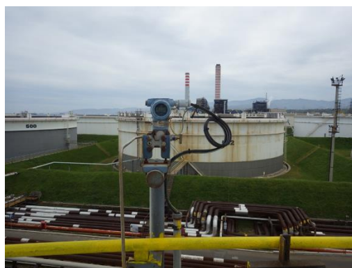
Figura 41 Bacini di contenimento in terrapieno con argine in terra
