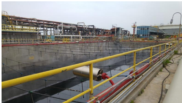
Figura 14 Vasca V309, dotata di dispositivi di nebulizzazione
