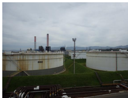
Figura 41 Bacini di contenimento in terrapieno con argine in terra
